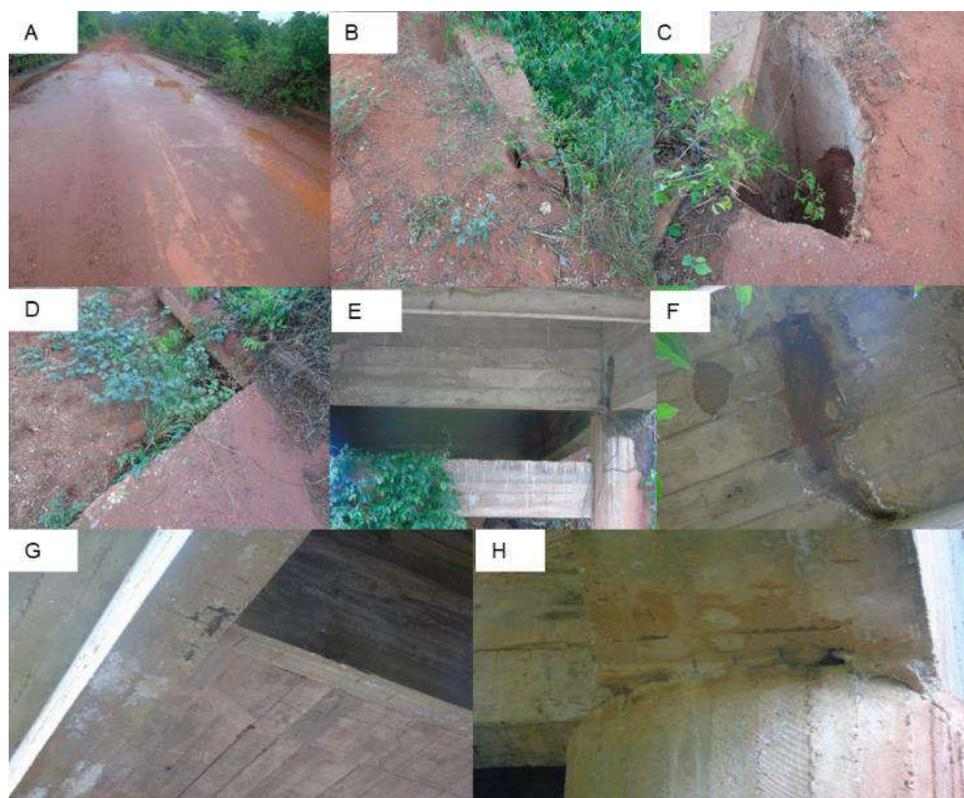
**Figura 2.** (A) terra e vegetação sobre a ponte, (B) erosão na parte direita da ponte, (C) erosão na parte esquerda da ponte, (D) erosão no outro lado na parte direita da cabeceira da ponte, (E) exsudação na viga transversal, (F) dreno entupido, (G) viga com armadura exposta com oxidação, (H) junção viga pilar com armadura exposta com oxidação.
